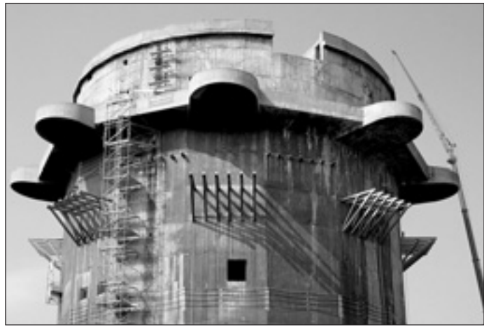
Die Baustelle Augarten-Flakturm ist beendet. Foto: apa
