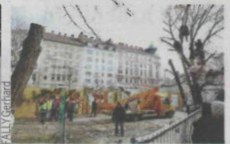
Hier wird Konzertsaal gebaut.
